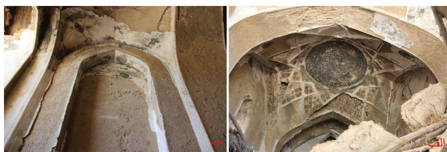
تصویر ۱۱: باغ و عمارت عباس‌آباد؛ الف) تزیینات کاربندی سقف تالار مرکزی کوشک، ب) آثار رنگ‌آمیزی و ابزار اندازی بر گچ در فضای داخلی کوشک (نگارنده، ۱۳۹۲).
