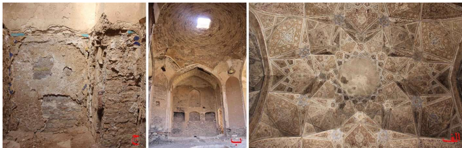
تصویر ۹: باغ و عمارت تاج آباد: الف) تزئینات یزدی بندی و نقاشی دیواری بر طاق کوشک هشتمی، ب) نمای داخلی کوشک گلاب‌گیری، ج) داغ تزئینات کاشی‌کاری در ازاره حمام (نگارنده، ۱۳۹۲).
