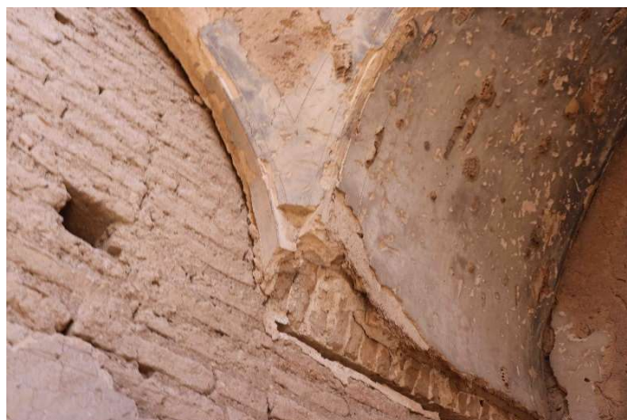
تصویر ۵: عمارت دمبی؛ تزئینات ابزار اندازی بر گچ (نگارنده، ۱۳۹۸).
