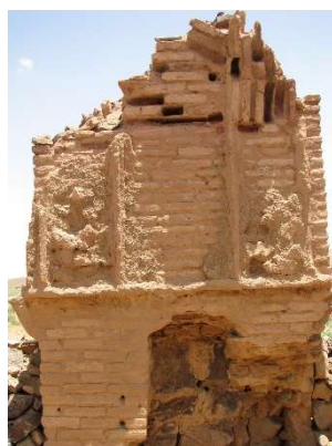
تصویر ۷: عمارت چاه رباط، نغول گچی و ابزاراندازی بر آن (نگارنده، ۱۳۸۴).
