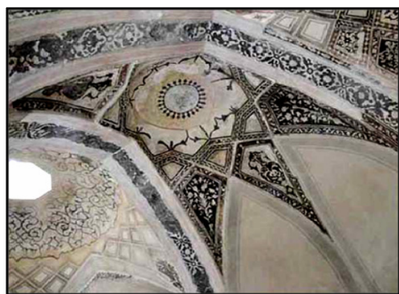
شکل ۶. کاربندی در فضای بینه حمام وکیل، (نگارنده)
