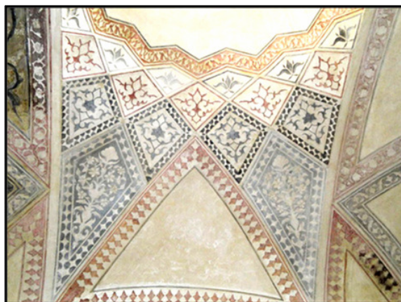
شکل ۵. کاربندی، هشتی ورودی حمام وکیل، (نگارنده)
